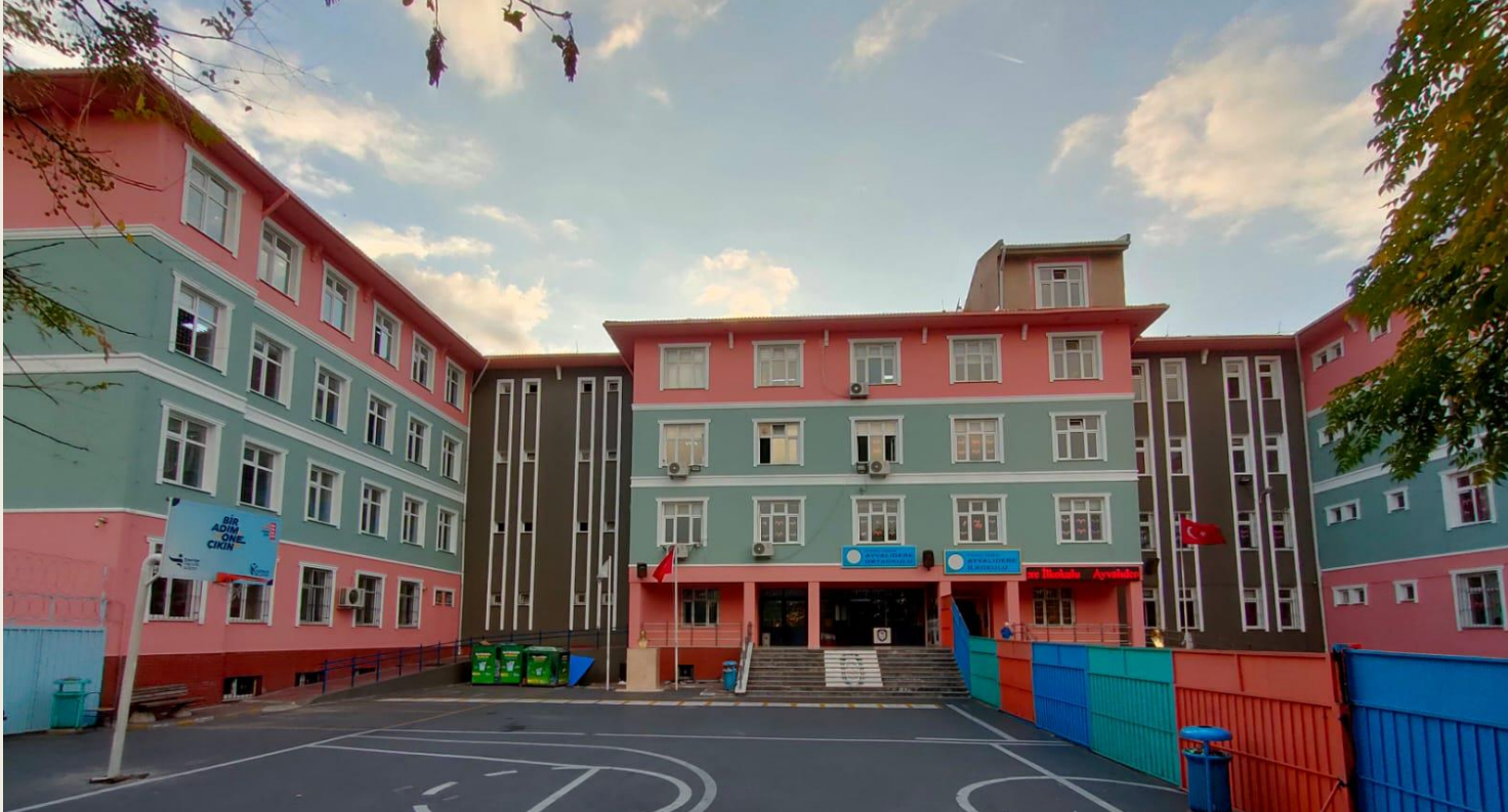
Şekil 1: Ayvalıdere Ortaokulu Önden Görünüm
